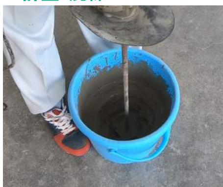
所定量計量した水にハンドミキサー等で攪拌しながら徐々に材料を投入し、十分混練します。
