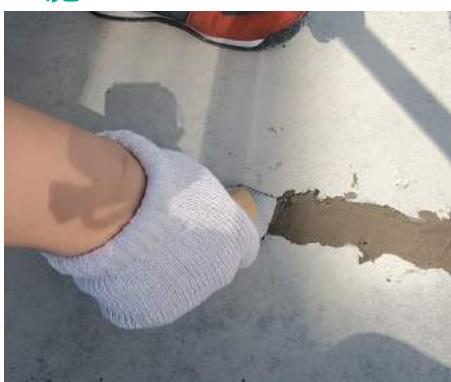
コテ圧をかけながら下地に密着するように施工します。1層あたりの塗厚は約5mm程度とし、その後所定の厚さまで塗り重ねます。
