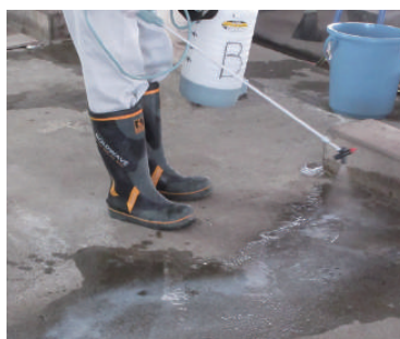
噴霧器による施工
