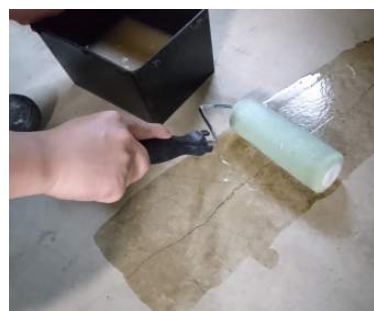
ローラー、ハケによる施工
