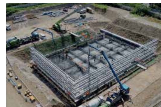
札幌市水道局 大型池状構造物
