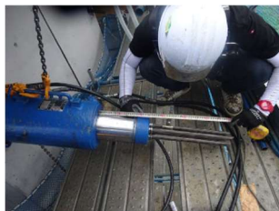
梁及び柱部材へのプレストレス導入
