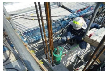
梁及び柱部材へのプレストレス導入
