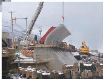
現地据え付け状況
