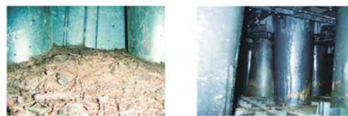
堆砂抑制システム内部 約10cmの土砂堆積 流出接続管付近 点検孔部 ほぼ土砂堆積なし
