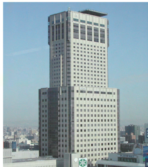
左上 D グラフォート 耐圧盤：フライアッシュコンクリート 柱：CFT(落込み打設)・高強度コンクリート 梁・スラブ：高強度コンクリート 左下 JR タワー 柱：CFT(圧入打設)・高強度コンクリート スラブ：軽量コンクリート 梁：高強度コンクリート 右 ノルペサ 柱：CFT(圧入打設)・高強度コンクリート
