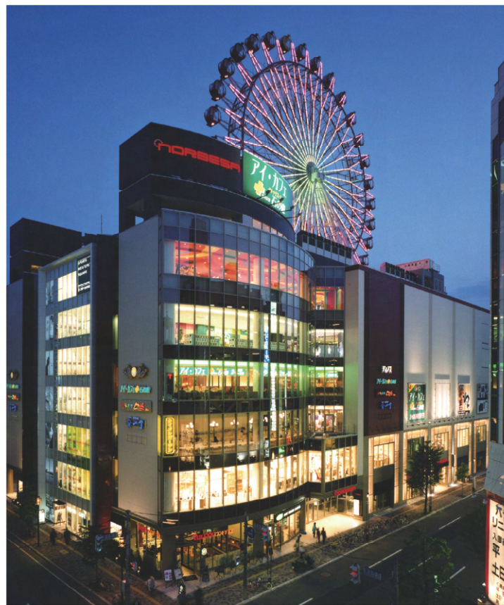
左上 D グラフォート 耐圧盤：フライアッシュコンクリート 柱：CFT(落込み打設)・高強度コンクリート 梁・スラブ：高強度コンクリート 左下 JR タワー 柱：CFT(圧入打設)・高強度コンクリート スラブ：軽量コンクリート 梁：高強度コンクリート 右 ノルペサ 柱：CFT(圧入打設)・高強度コンクリート
