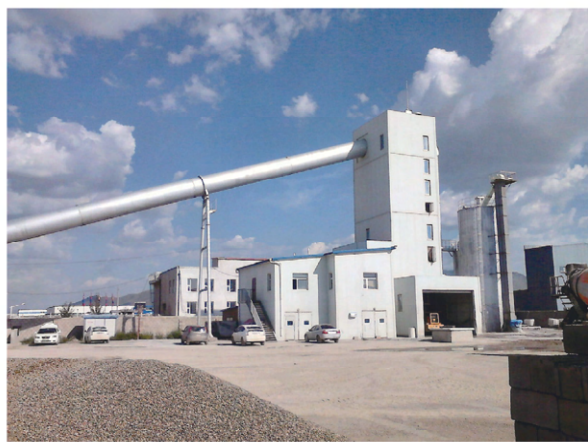
バッチャープラント
