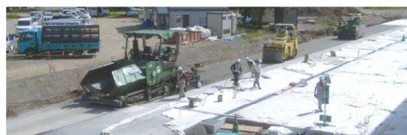
ローラー転圧コンクリート舗装 (RCCP)
