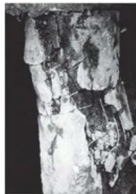
杭頭を剛接した杭の被害例
