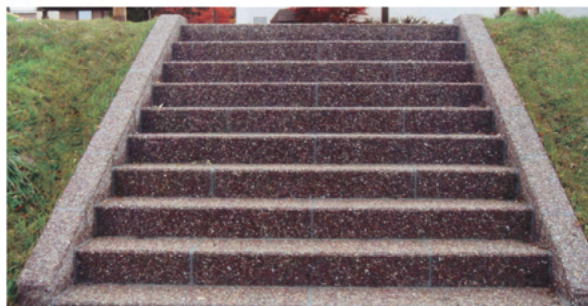
洗い出し階段・袖ブロック ATCレッド
