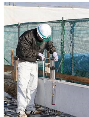
基礎梁部分のレベル調整作業
