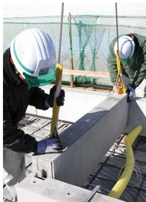
PCa 基礎梁の設置作業
