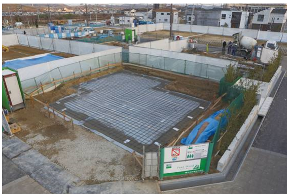
PCa 基礎梁の設置前
